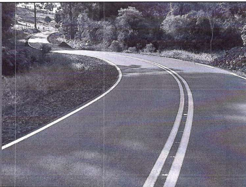
Asfalto entre Francisco Beltrão e Bom Sucesso do Sul 2º Trecho
