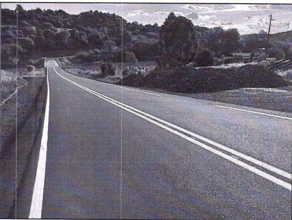
Asfalto entre Francisco Beltrão e Bom Sucesso do Sul 2º Trecho
