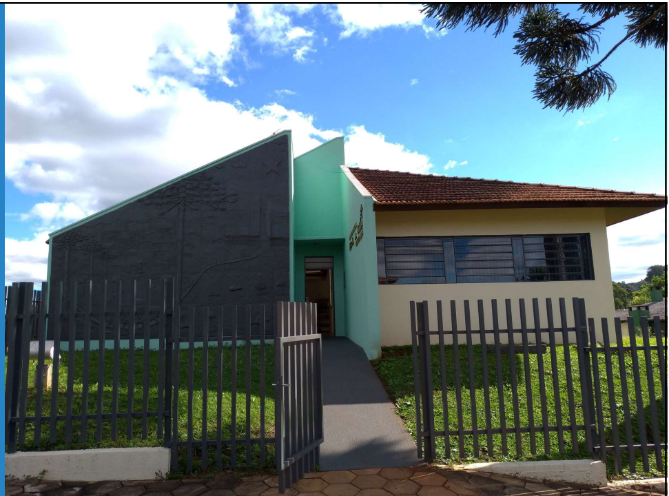
Reforma e Pintura Biblioteca Municipal Estrela da Cultura
